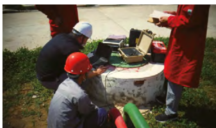
Трубопровод при прохождении под дорогой
