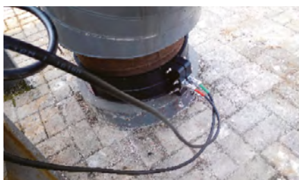
Заходы трубопровода в землю
