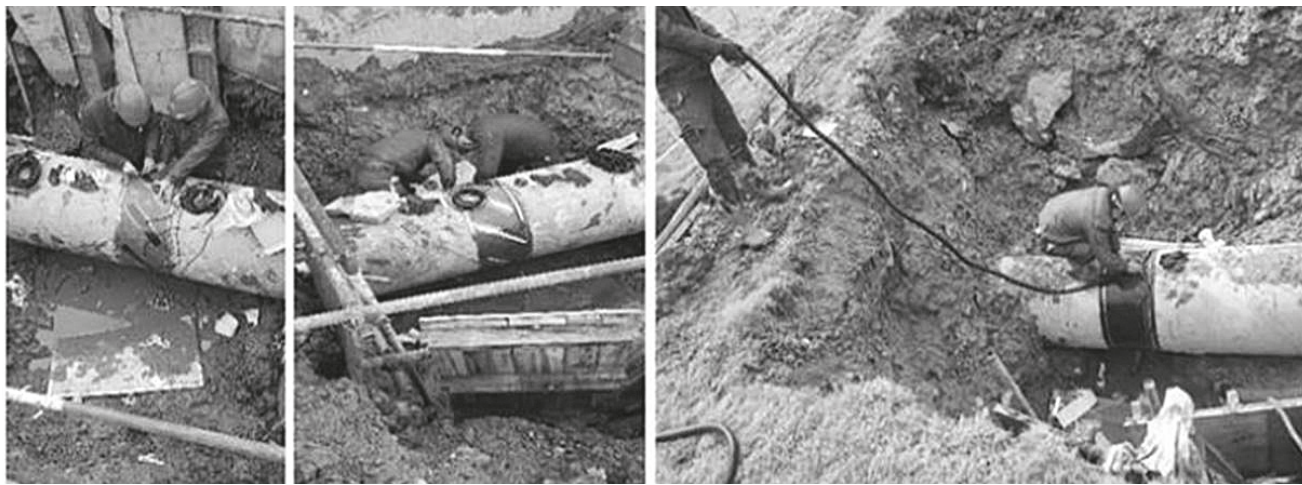
Магнитострикционные системы неразрушающего контроля KTS-MD30 – диагностика на расстоянии
