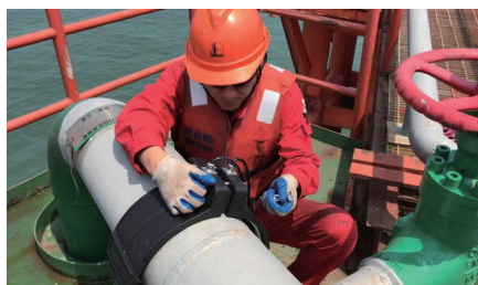
Трубопровод морской платформы
